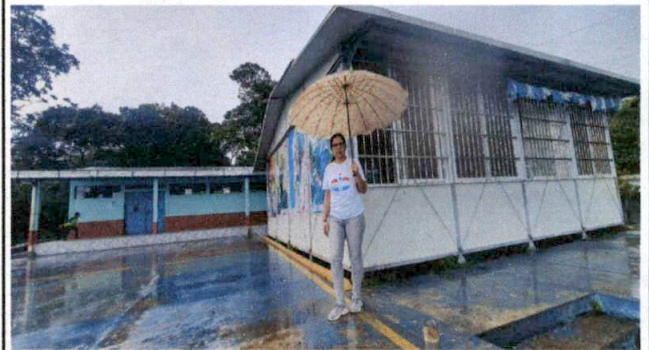
Foto 8: Vista a módulos de aulas
